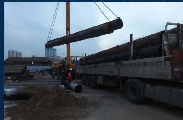
27.10.21 г. труба  $\text{Ø} 530 \times 8 \text{ мм}$
