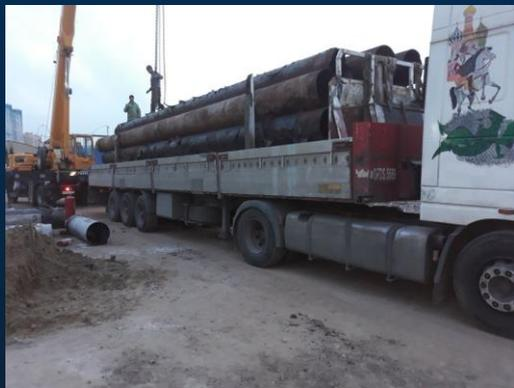
06.10.21 г. труба б/у  $\text{Ø} 720 \times 10 \text{ мм}$
