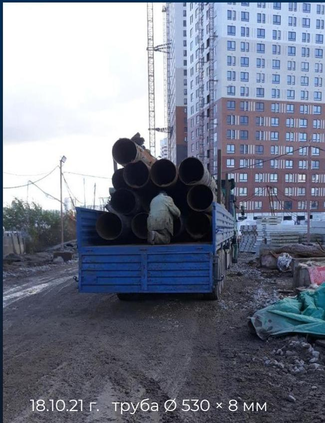
18.10.21 г. труба  $\text{Ø} 530 \times 8 \text{ мм}$
